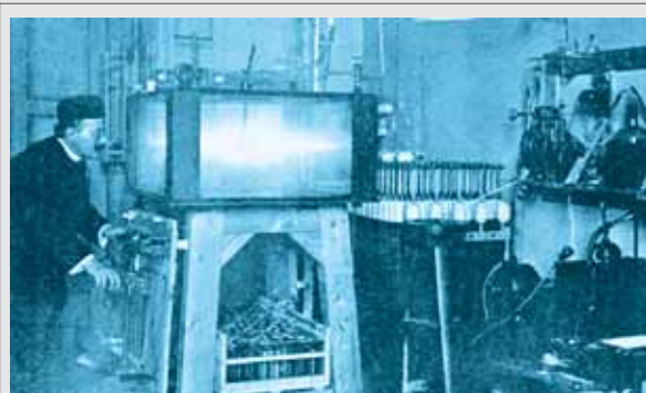
▲ کریستین بریکلند شفق قطبی را هم در طبیعت و هم در آزمایشگاه خود مطالعه می‌کند. در اینجا او با تولا (به معنی زمین کوچک) دیده می‌شود که کره‌ای مغناطیسه درون یک جعبه خلا است.
